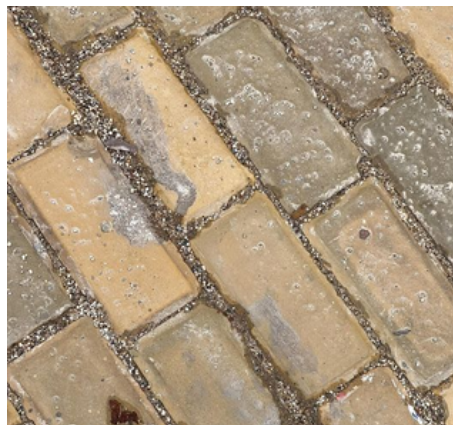
След новия ремонт 28.09.23 г.
