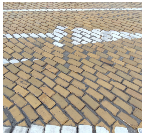
Седмица след ремонта 27.09.22 г.
